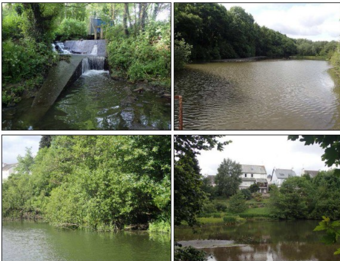
Figure 25 : Vues de l'ouvrage de retenue, du plan d'eau depuis l'amont, de la ripisylve arborée en rivegauche et de la strate herbacée en queue d'étang (Source : CERESA)
