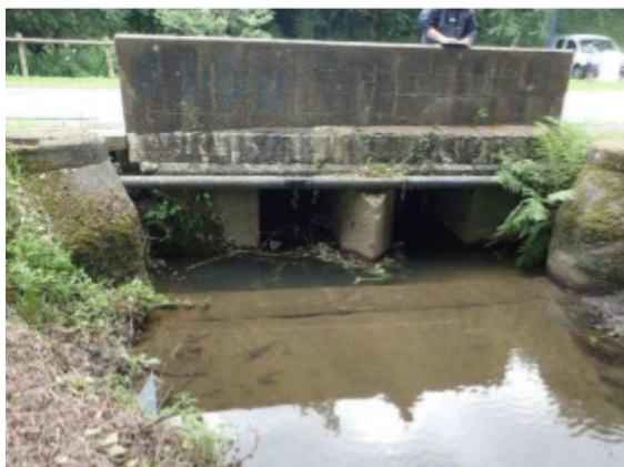
Figure 19 : Le pont de béton
