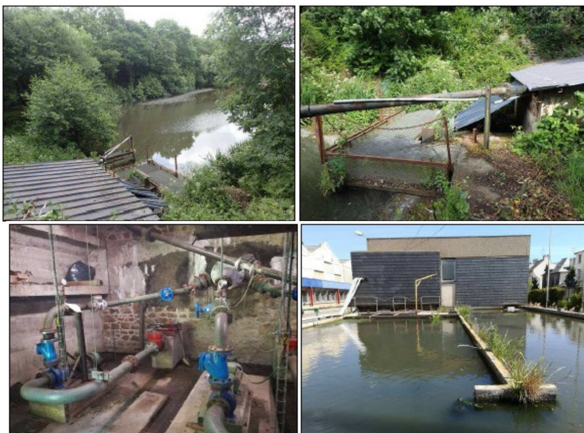
Figure 21 : Vues de la station de pompage de l'extérieur (en haut) et de l'intérieur (en bas à gauche) ainsi que du bassin de refoulement au niveau de Manoir Industries (en bas à droite). Source : CERESA
